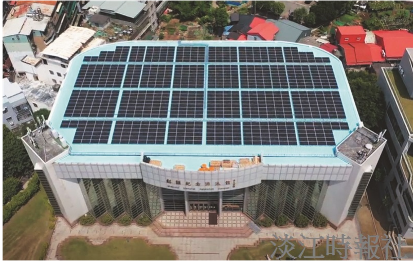
總務處暑假期間於體育館與游泳館頂樓設置太陽能發電系統，預計於10月正式運作。（圖／總務處提供）
