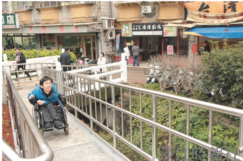
節能與空間組於寒假時，在鄰近大學城的翰林橋旁設置無障礙坡道。（攝影／姜智越）
