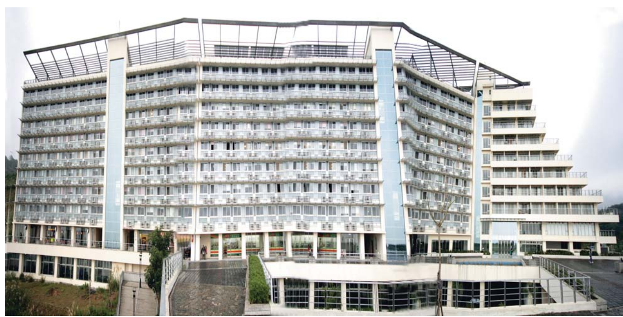
▲ 蘭陽校園綠建築主體，其外型像一艘大船，具有騰程萬里的意義，以不破壞山坡地的面貌為原則，打造符合環境保育與省能節源的綠建築典範。(涂嘉翔攝)
