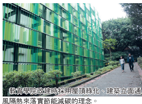
教育學院改建時採用屋頂綠化、建築立面通風隔熱來落實節能減碳的理念。
