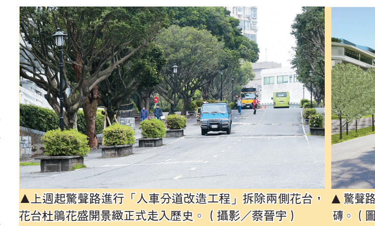
▲上週起驚聲路進行「人車分道改造工程」，拆除兩側花台，花台杜鵑花盛開景觀正式走入歷史。(攝影/蔡晉宇)
